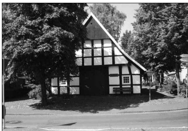
Het Heimathaus in Berge.
